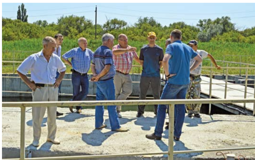
Рыбозащитное сооружение НС-42
